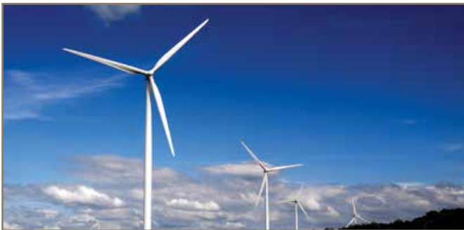
Stromerzeugung: Gute Eignung für die Überwachung von Hydraulikgetrieben (Neigungs- und Bremssysteme bei der Windenergiegewinnung) - Qualität als Bestandteil eines geplanten Wartungsprogramms
